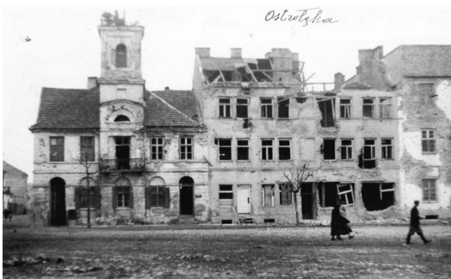
Il. 16. Zniszczone kamienice w rynku w Ostrołęce, 1945 r. (AAN, Ministerstwo Apropowizacji w Warszawie, Memoriał w sprawie pomocy zniszczonym północnym powiatom woj. warszawskiego, sygn. 168, k. 21)
